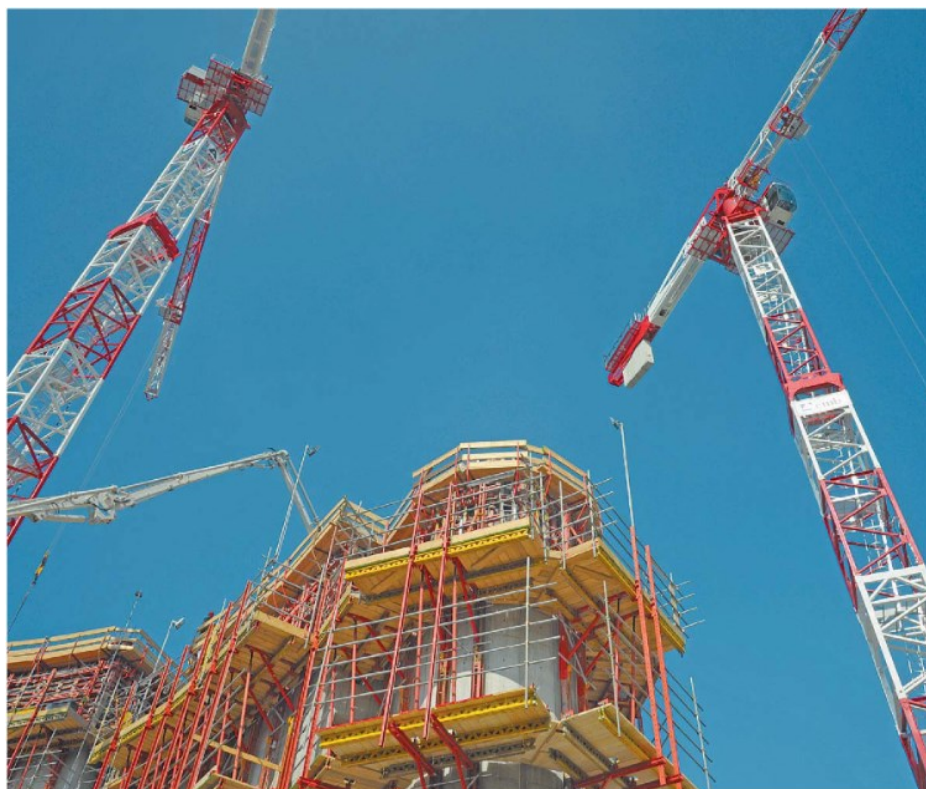
Uno dei cantieri edilizi nell'area di Porta Nuova; c'è preoccupazione nel settore per il rallentamento delle pratiche edilizie (Ftg)
