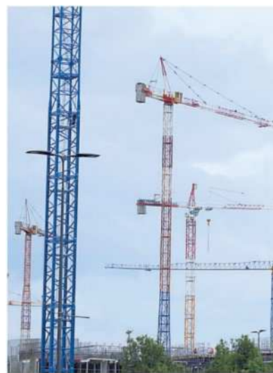
▲ Edilizia Le gru della Milano che cresce
