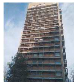
La torre di via Cilea
