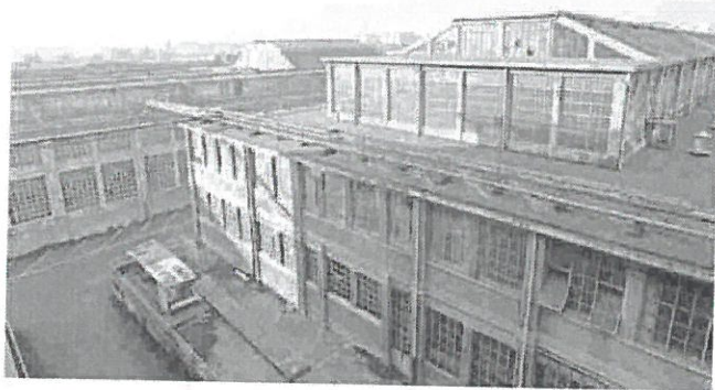
Il complesso tra corso Vigevano e via Cuneo
